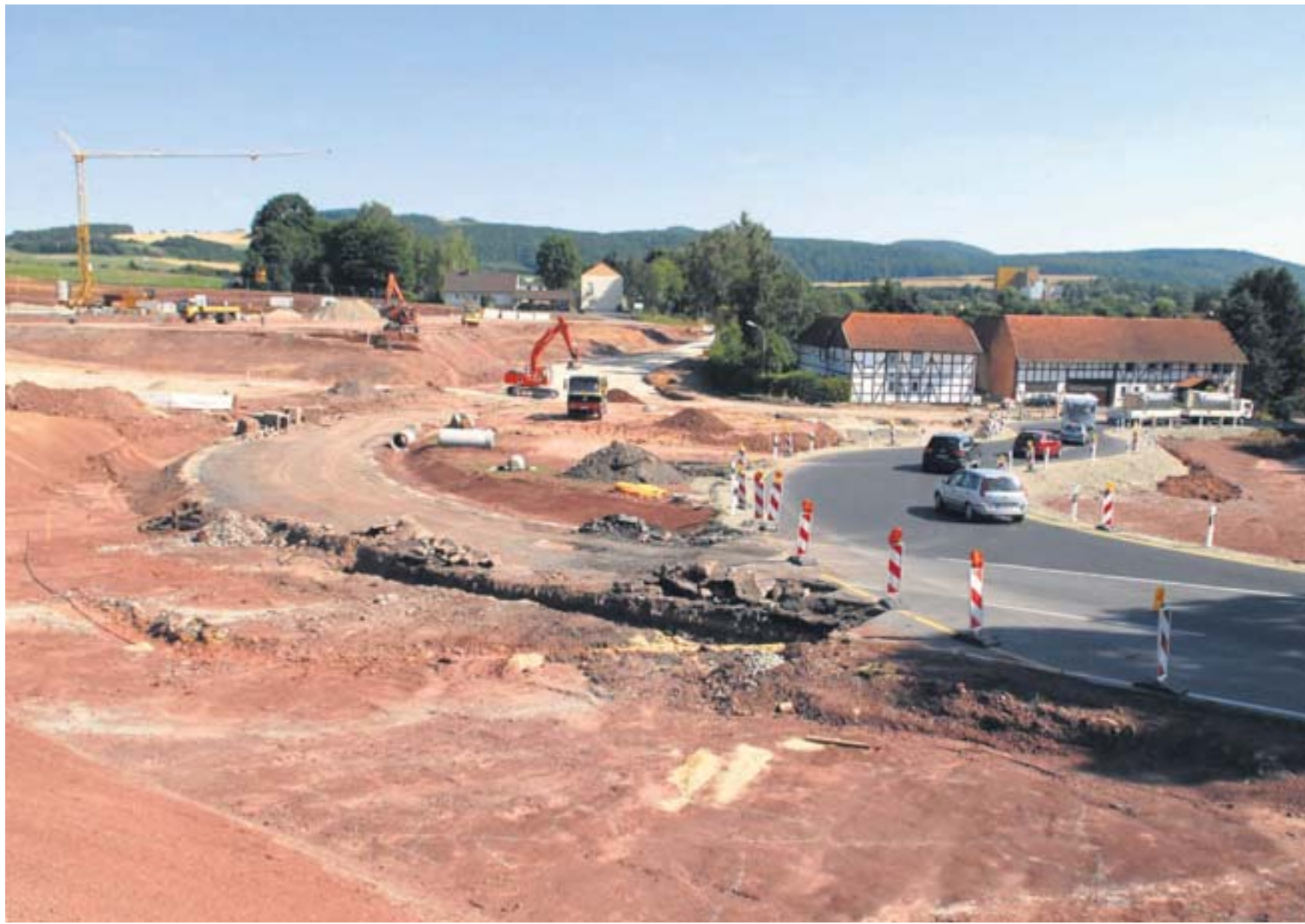
Mondlandschaft an der B3: Der Bau eines fünfarmigen Kreisels vor Scheden ist im vollen Gang, im neuen Gewerbegebiet hinten links wird ein Supermarkt gebaut. CH
